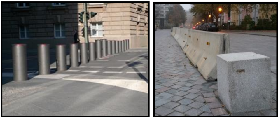
Abbildung 2: Terror-Poller, links versenkbare Poller, rechts Jersey-Barriere und Beton-Poller
